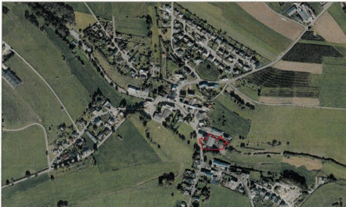
Abbildung 1: Luftbild von Hostert mit Verortung des Plangebietes (rot). Quelle: orthophoto 2021, verändert nach CO3 2022
