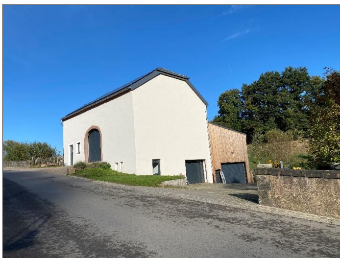
Abbildung 4: kommunal denkmalgeschütztes Gebäude. Quelle: CO3 2022
