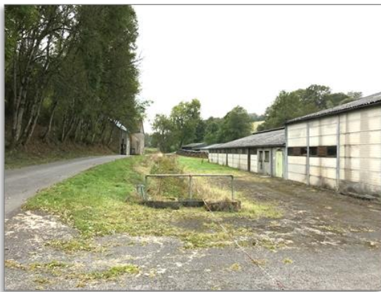
Abb. 3: Blick entlang der südlichen Plangebietsgrenze an der „Rue de la Mairie“
