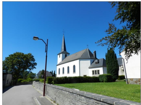
Abb. 6: Blickbeziehung 6 – Richtung Westen
