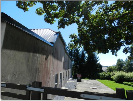
Abb. 1: Blickbeziehung 1 – Richtung Süden
