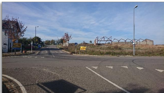
Abb. 7: Blick von der Kreuzung „Rue de Holtz“ (C.R. 310) und der „Route de Perlé“ (C.R. 311) auf das Plangebiet
