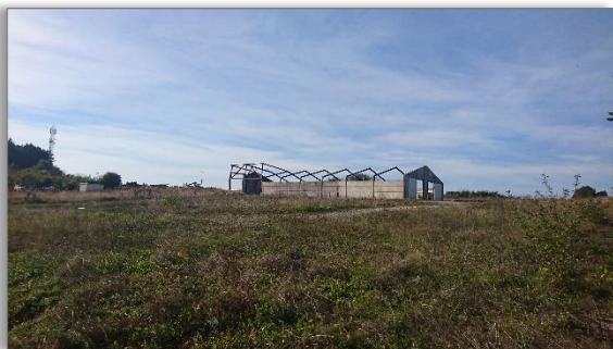
Abb. 5: Blick von der südlichen Plangebietsgrenze nach Nordwesten
