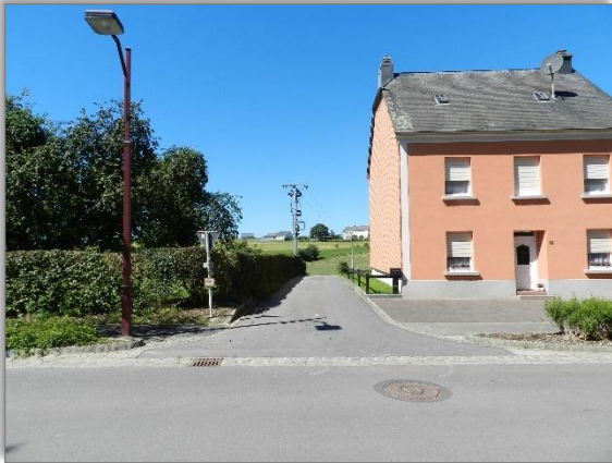
Abb. 1: Blick auf den von der „Rue des Romains“ abzweigenden Feldweg in das Plangebiet
