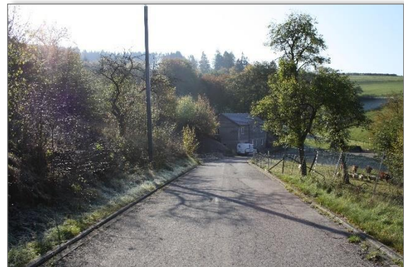
Abb. 4: Blick entlang der zentral durch das Plangebiet verlaufende „Rue Abbé Neuens“ nach Süden und die südlich angrenzende Bestandsbebauung
