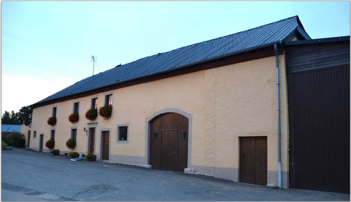
Abb. 6: Bestehendes Wohngebäude an der „Rue des Romains“, das erhalten werden sollte. Quelle: SSMN 2016
