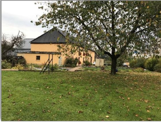
Abb. 1: Blick von der „Rue des Romains“ auf das Wohngebäude
