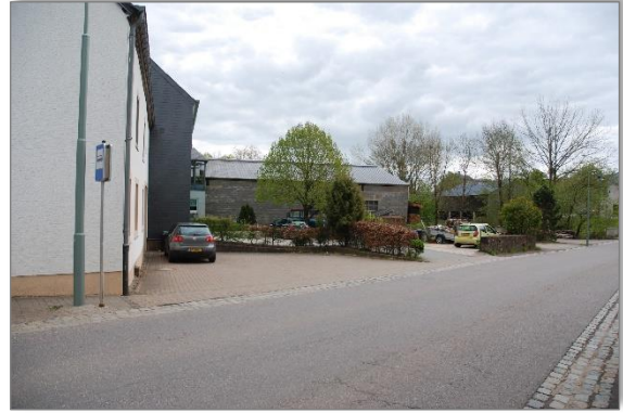
Abb. 2: Blick von der „Rue Principale“ auf das bestehende landwirtschaftliche Nutzgebäude
