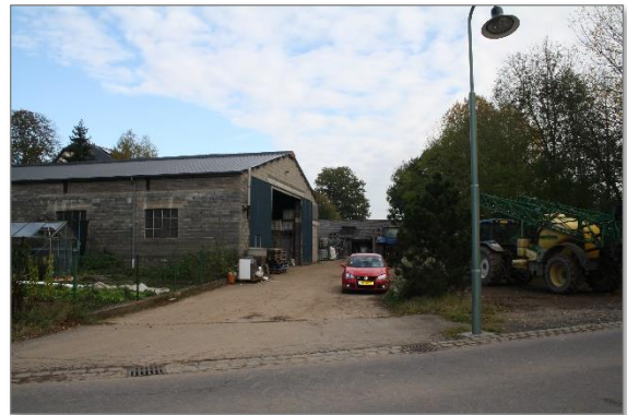
Abb. 4: Blick auf die Zufahrt von der „Rue Principale“ zum Plangebiet
