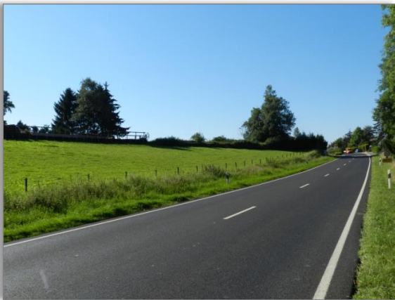
Abb. 3: Blick entlang der westlichen Plangebietsgrenze an der „Rue Principale“ (N 23) nach Südwesten
