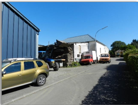
Abb. 3: Blick auf die bestehende Zufahrt von der „Rue du Brill“ zum Plangebiet
