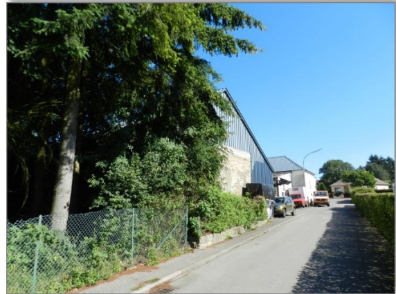
Abb. 2: Blick entlang der südlichen Plangebietsgrenze an der „Rue du Brill“ in Richtung Nordosten
