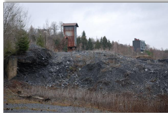
Abb. 14: Blick auf Förderturm (Ausbildung eines Plateaus zwischen Förderturm und Bachlauf)
