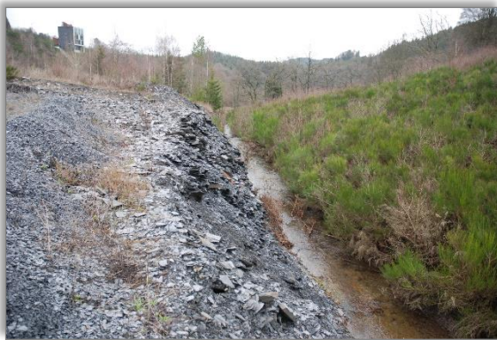
Abb. 13: Bachlauf östlich des Plangebiets (Optimierung der Zugänglichkeit des Bachlaufs „Heemicht“)
