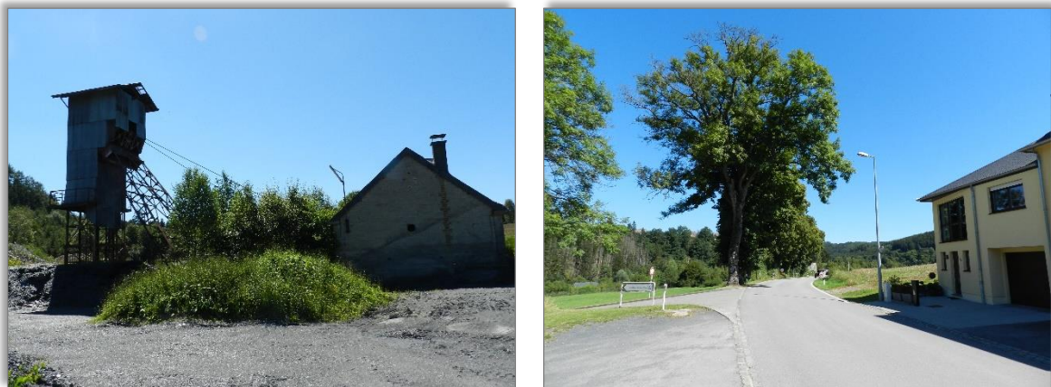
Abb. 11: Blick auf den Förderturm des ehemaligen Schieferbergbaus, der als Zeichen der Kulturlandschaft erhalten werden sollte (links), und die zu erhaltende Lindenbaumreihe an der „Route de Bigonville“ (rechts). Quelle: CO3 2016
