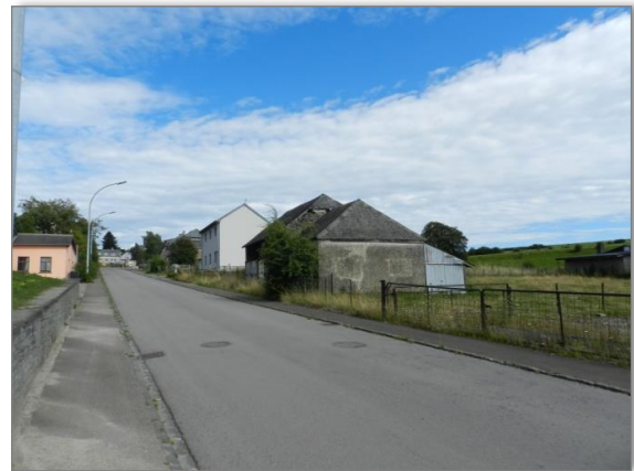
Abb. 4: Blick entlang der „Rue Principale“ nach Osten
